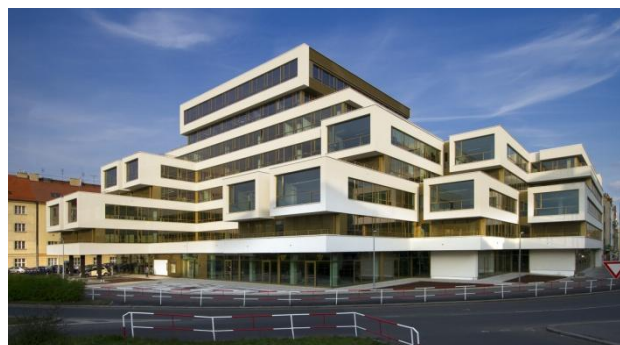
Multifunkční budova Qubix, Praha
