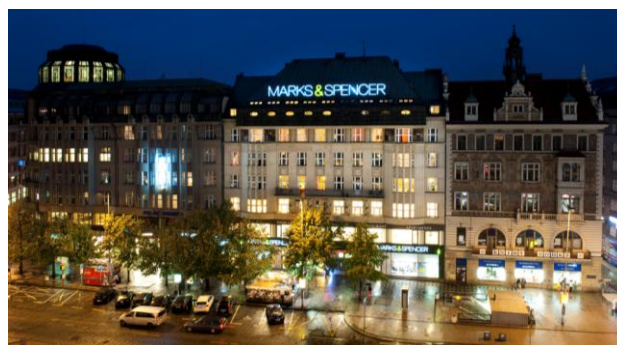
Multifunkční budova Melantrich, Praha
